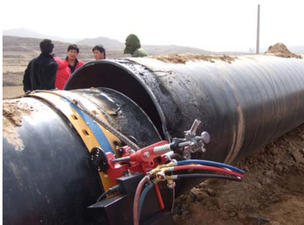
氧/汽油切割，开外坡口 (管外径1420mm，壁厚28mm，螺旋焊缝钢管)
