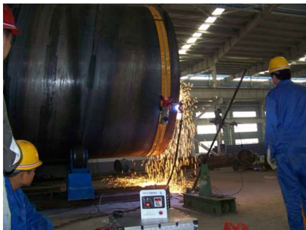
等离子切割，开“X”型带钝边坡口 (管外径3740mm，壁厚22mm，螺旋焊缝钢管)
