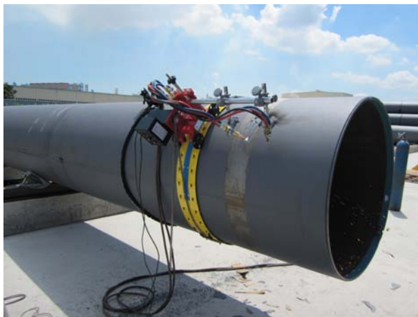
氧/乙炔切割，开外坡口 (管外径1067mm，壁厚14mm，直焊缝钢管)
